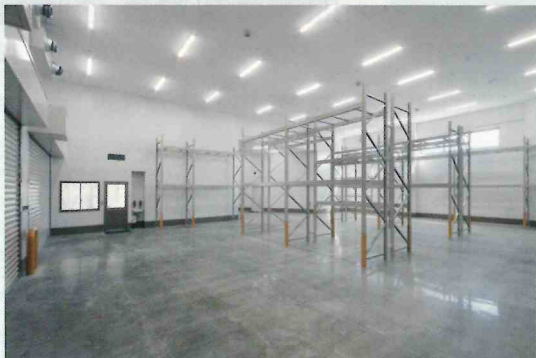
▲常温倉庫1, 2(写真は図内⑦)内は28℃以下に設定しています。左の扉は倉庫事務所(図内⑤)です。
