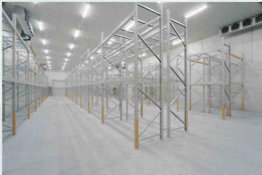
▲冷凍庫(図内②)内は最低-25℃に設定が可能で、約230種類の物資が保管されています。
