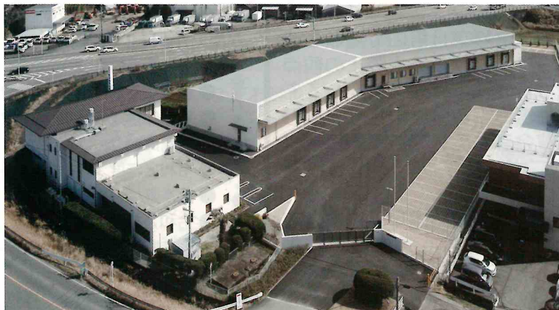
全景： 本館事務所棟・ 倉庫棟
